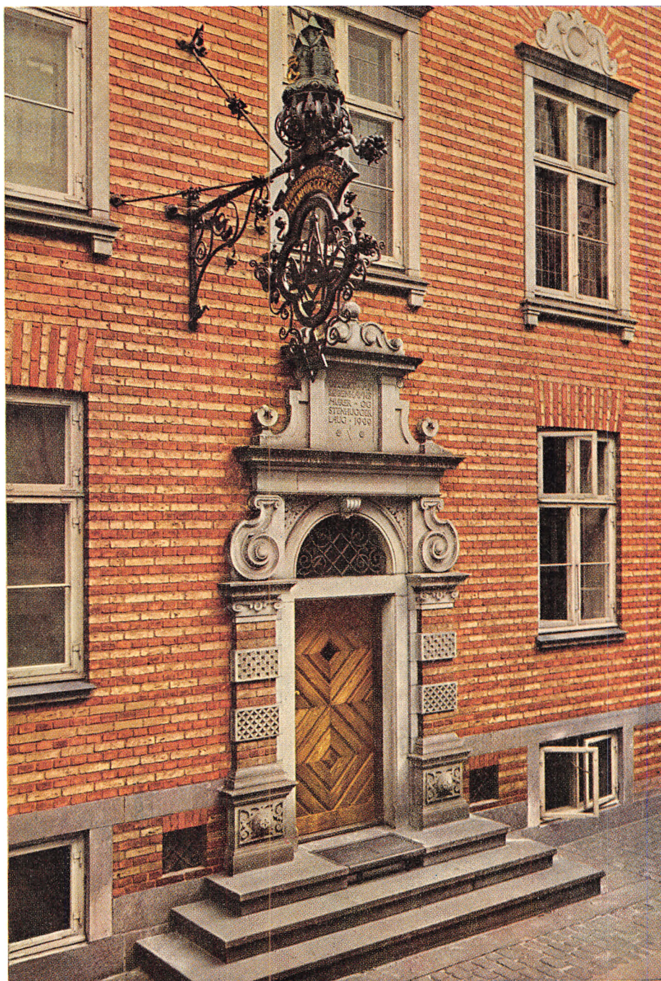
Københavns Murer- og Stenhuggerlaug: Indgangsportal til Lavets Ejendom paa St. Annæplads.
