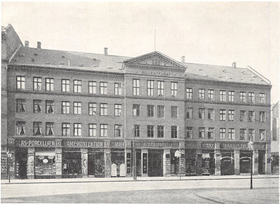
Alderstøt paa Nørrebrogade, opført 1862-63. (Fot. fra 1930).
