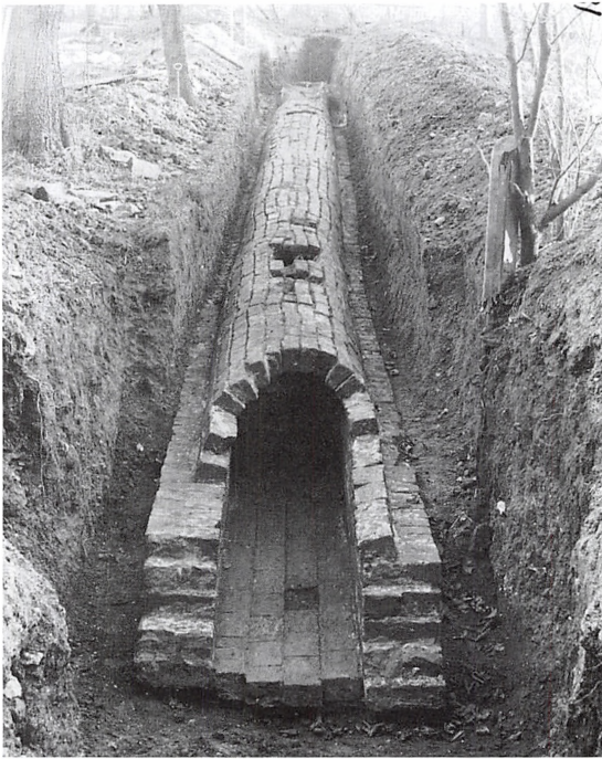
Udgravning af kloakledning på slotsbanken ved Koldinghus 1900.
