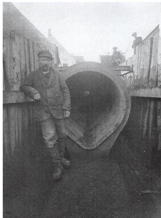
Kloakrør nedlægges på Fremads grund i Låsbygade, november 1922.
