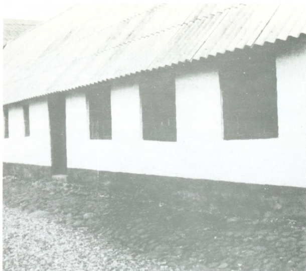
Den gamle længe på Tøttrupgaard. Bemærk brolægningen
