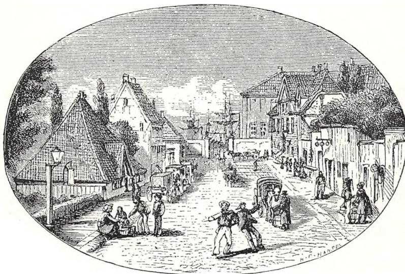
„Brokkensbod“ paa Toldbodvejen, første Hus paa venstre Haand. Det store Hus paa højre Haand, med Frontispicen, er „Toldbod Vinhus“.
