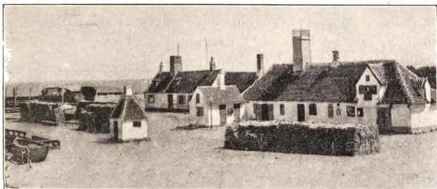
Havnelokalet og Lodshuset (bag ved)
