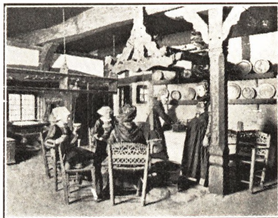
Interiør fra samme Gaard: „Dilen“ med det aabne Ildsted.
