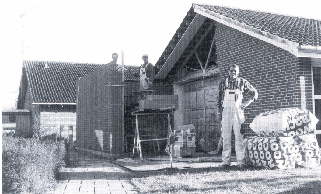
Hans Storm og murersvende i arbejde på Møller Eriksensvej
