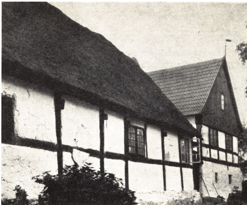
Bornholm. Rabekkegård i Ibsker ved Hasle. Stuehusgavl med høj kælder og med knægte på hjørnestolperne.
