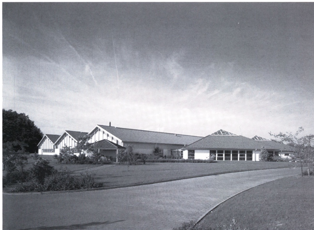
3L 1989. Det første der blev bygget på industrigrunden i Brylle.
