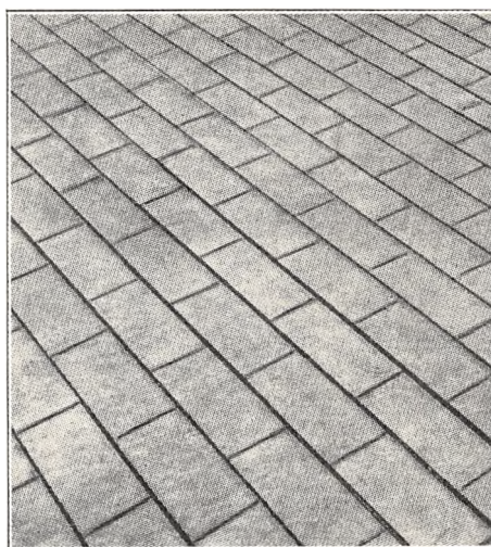
Fig. 9. Gulv af Klinker (gammelt og meget brugt).
