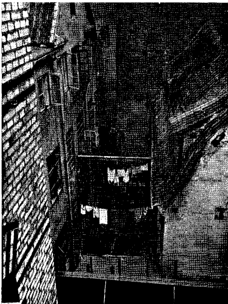
Et mere end 200 år gammelt og smukt forhus (til venstre i billedet), oprindelig beboet af velhavende borgere, men nedsunken til slum på grund af baghuse og brandgavle til gårdsiden.
