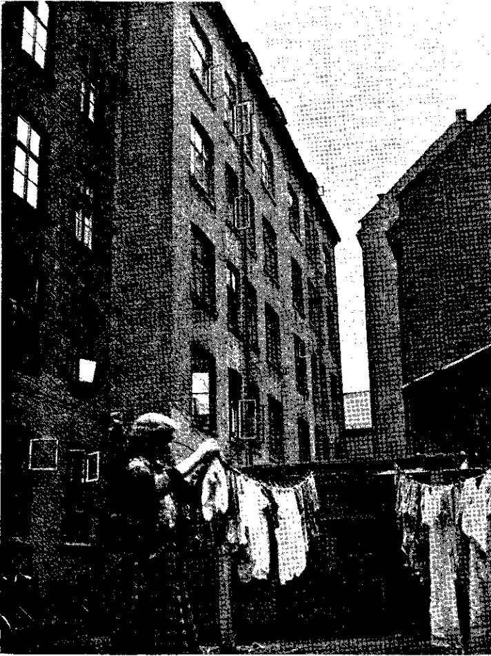
Baghusbebyggelse på Vesterbro fra den mellem Saxogade og Westend beliggende karre, som for tiden er taget op til sanering gennem kondemnering med påfølgende udbuling ved fjernelse af karreens baghuse og bevaring af forhusene.
