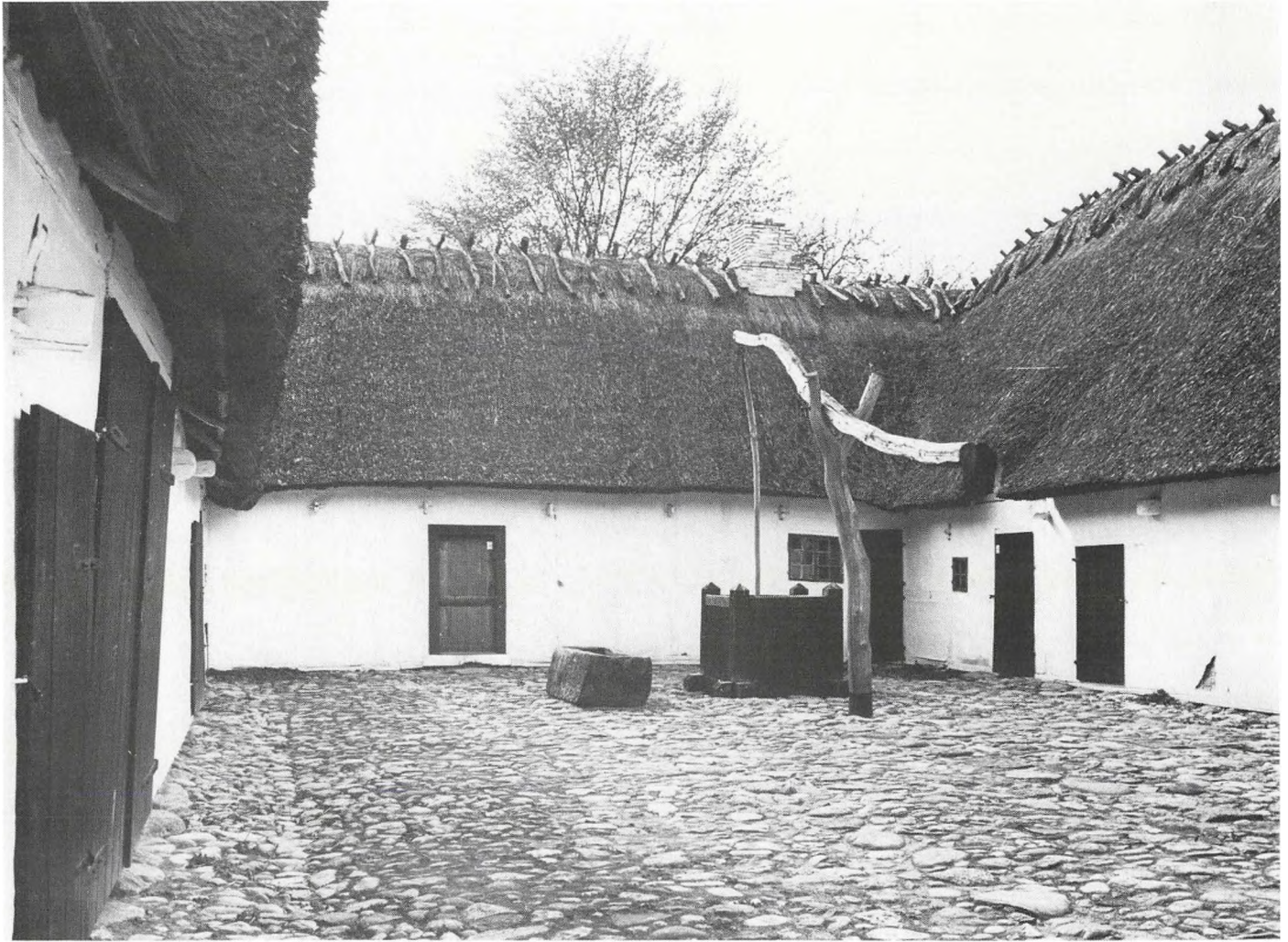
Fig. 2. Gårdspladsen i Falstergården med vippebrønden.
