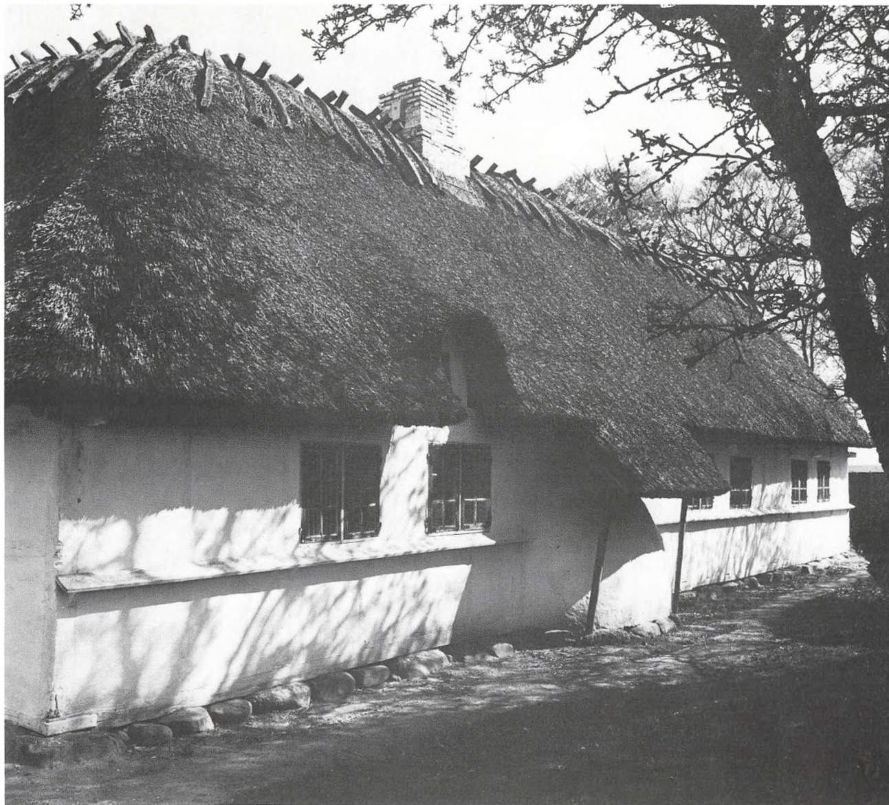
Fig. 3. Falstergårdens stuehus set fra nordvest. Under halvtaget stikker bageovnen ud.
