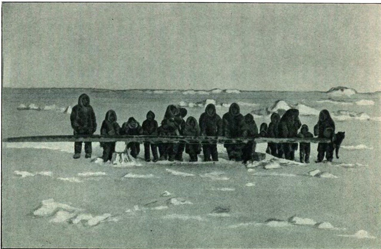
Typisk Slæde, der med en god Isskoning og kun forspændt med to til tre Hunde med Lethed fragter selv de mest velhavende Familiers Ejendele. Opstan- derne bagtil bruges ikke som i Grønland, men Slæden styres forfra gennem Læssets Surringer. Slæderejser er aldrig magelige Passagerfarter; alle Familiens Medlemmer maa gaa, kun gamle og svagelige anbringes paa Toppen af Læsset.
