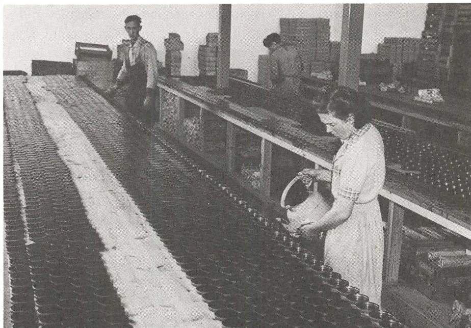
Der hældes skocreme op. Billedet stammer fra de første år i den nye fabrik på Dollerupvej og viser, at produktionsprocessen ikke var automatiseret. Skosværtten er blevet hældt på en gammel kedel og bliver derfra hældt op i dåserne. Foto i privateje.
