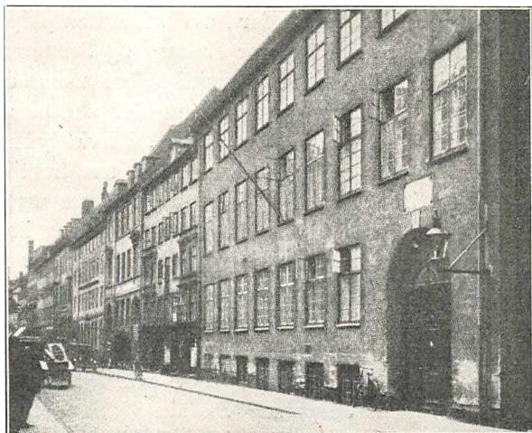
Fig. 11. Den gamle polytekniske Lærestalts Bygning i Studiestræde (nu Universitetskvæstur). Over Porten en Mindeplade for H. C. Ørsted. (Efter J. T. Lundbye 1929).
