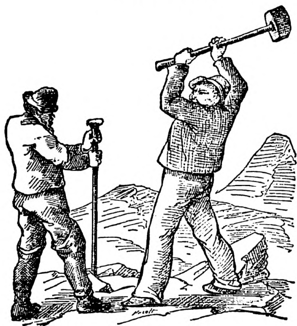
Bjergsprængning. en retstaffen og ærlig Arbeider.
