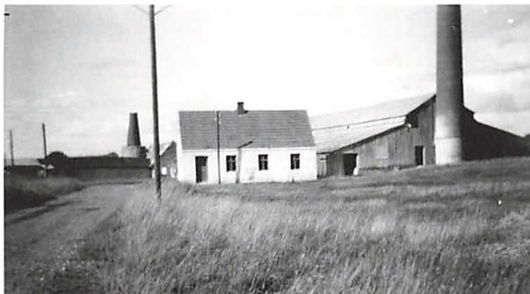
Vejerhuset (foto fra ca. 1959). Der er her ført elektricitet til kalkværket.
