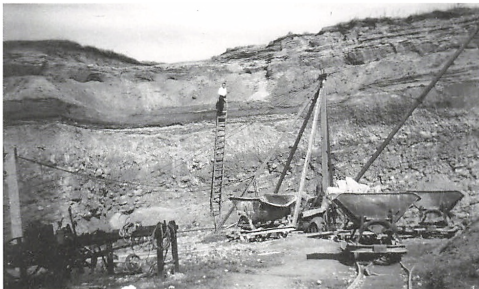
Spil, bomme og tipvogne (foto fra 1958). Spillet blev drevet af en elmotor, som via en gammel gearkasse fra en bil kunne hejse kasserne med kalk og flint op fra gravene.
