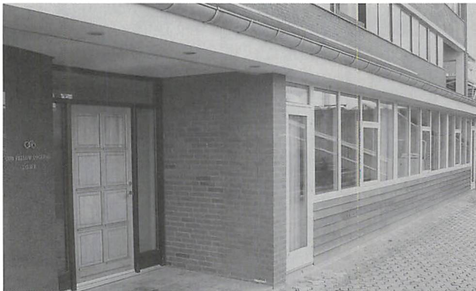
Logebygningen i Mindegade i Herning.
