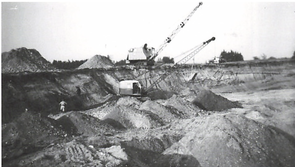
Store gravemaskiner i sving for at blotlægge kalken (april 1960).
