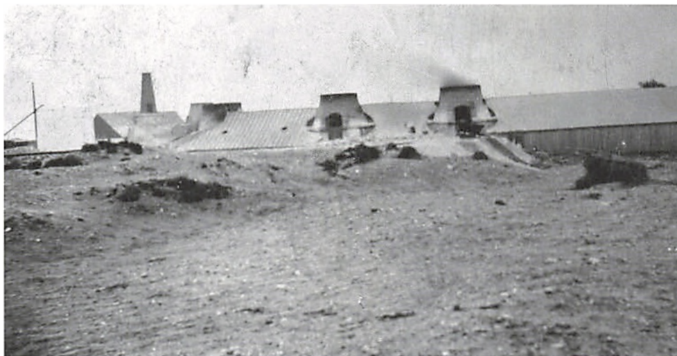
Ca. 1930. På billedet ses i alt fem kalkovne. De fire er af typen potovne, og den længst til venstre er en kontinuerlig brændende ovn. Helt til venstre på billedet anes et nybyggeri af endnu en ovn.
