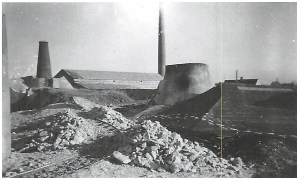
Tiprøgnssporet fører hen til kalkovnene. (Foto fra 1956). Forrest til venstre skimtes vandtårnet. Bag dette: En kontinuerligt brændende ovn med lagerbal. Med stor skorsten: Ringovnen med tilhørende lagerbal. Til højre: Den østligste af de tre potovne.
