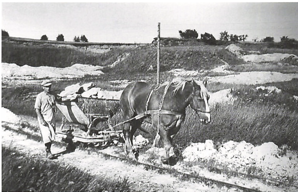
Ca. 1930. Harry Nielsen og besten Klaus på vej op mod ovnene med kalkblegerne. Fra kalkgravene gik der to tipvognsspor. Det ene gik op til kalkovnene, og det andet førte hen til brinken, hvor man deponerede »grasset« (flinteaffaldet).
