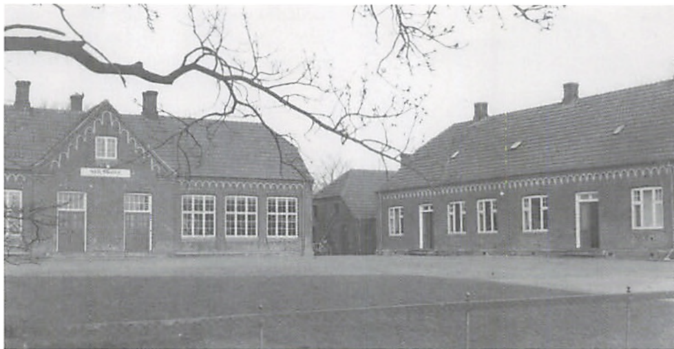
Sir Skole fra 1914. Bygningerne står endnu. Hovedbygningen indeholder de to klasseværelser. Sidefløjen rummer lærerinde- og lærerbolig.
