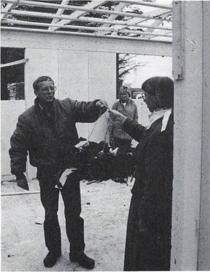
Rejsegilde på værkstedsbygningen ved moto-crossbanen.
