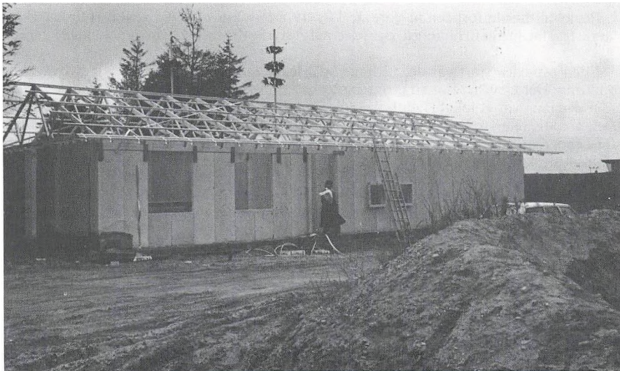
Rejsegilde på værkstedsbygningen ved moto-crossbanen.
