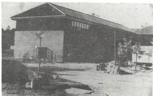
set fra syd-øst - endnu byggeplads.
