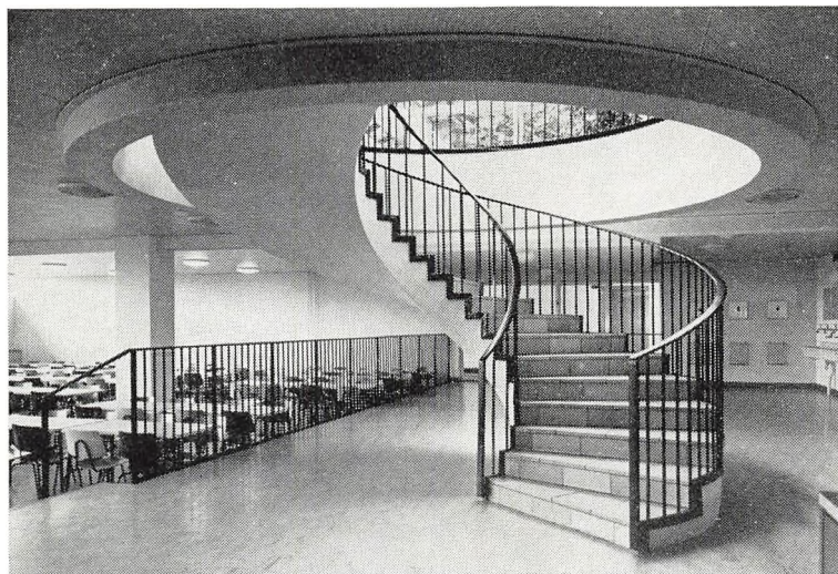
Nedgang til frokoststuen
