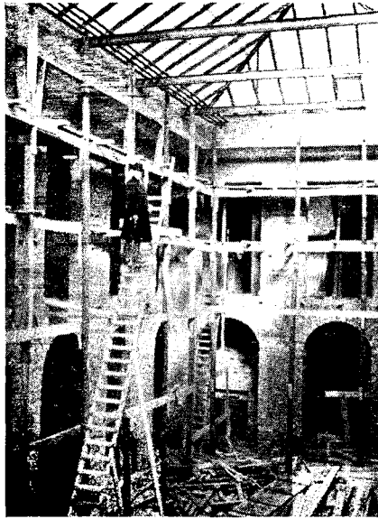
Fra Opførelsen af den nye Bygning. Paa Stigen Rektor Dietrich Petersen.
