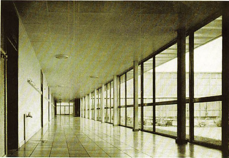
Korridor i sydflojen.
