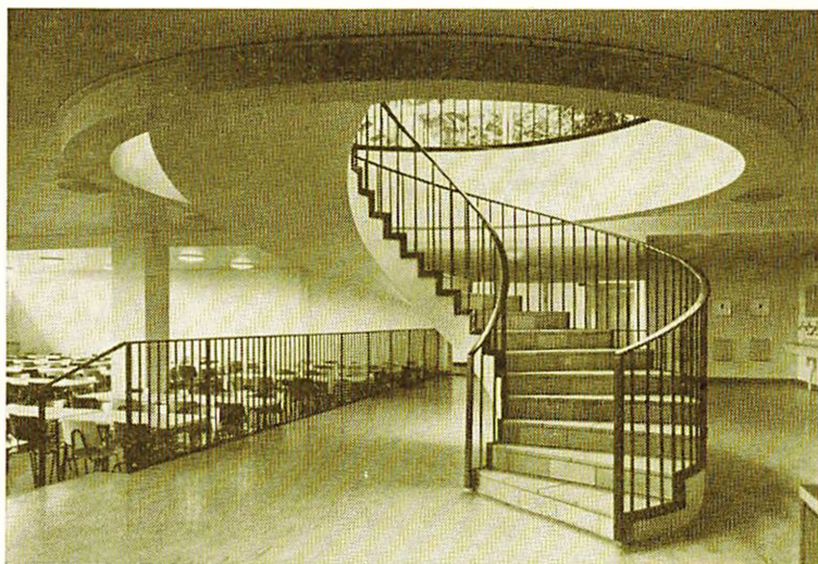
Nedgang til frokoststuen
