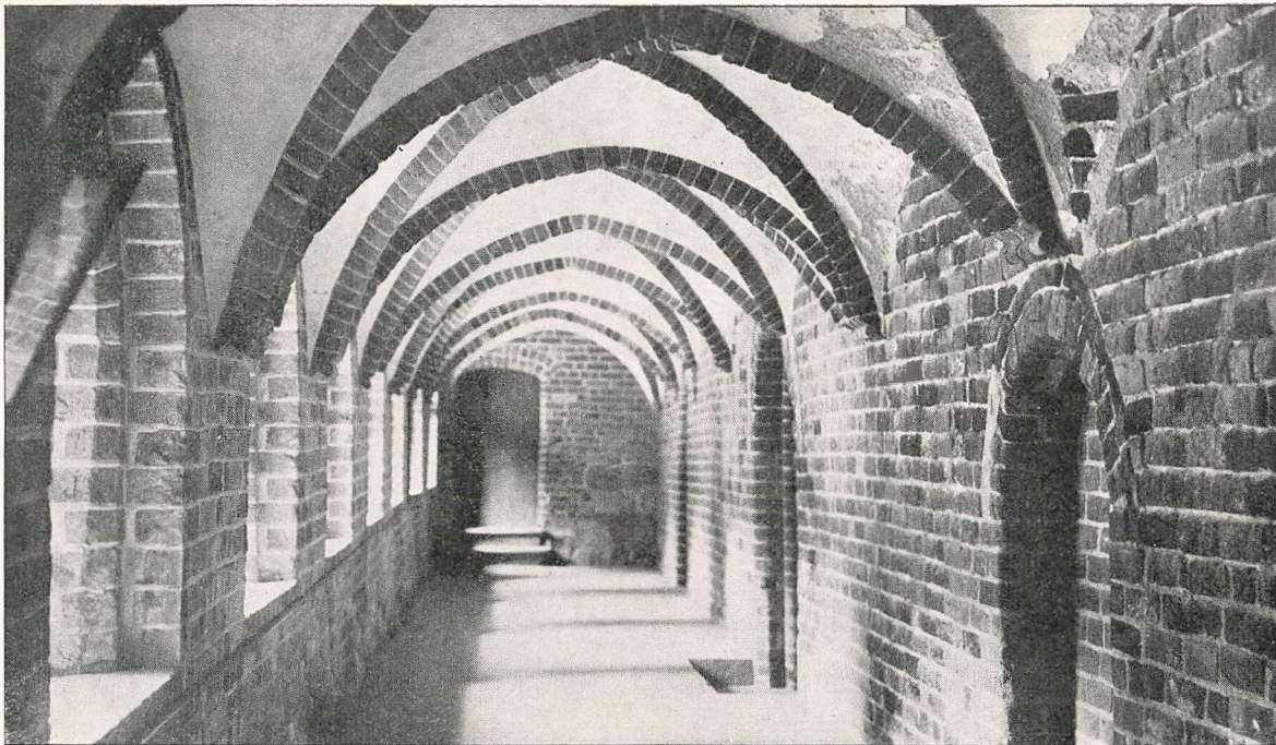
Fig. 7. Munkegang i Klosterbygningens Østfløj, opført af Abbed Oluf 1502. I Muren til højre (opført i det 13. Aarh.) ses Indgangen til Pillesalen. For Enden af Munkegangen Dør til Kirken. (S. 22).
