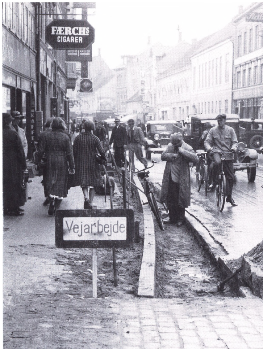
Vejarbejde i Vestergade nær Kongensgade i slutningen af 30'erne (E. Christoffersen fot., Møntergården).
