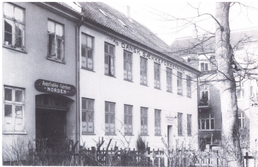
Et par af byens mellemstore virksomheder havde en overgang til huse i den gamle fattiggård ved Vindegade og Klostervej. Billedet er fra omkring 1920 (Møntergården).
