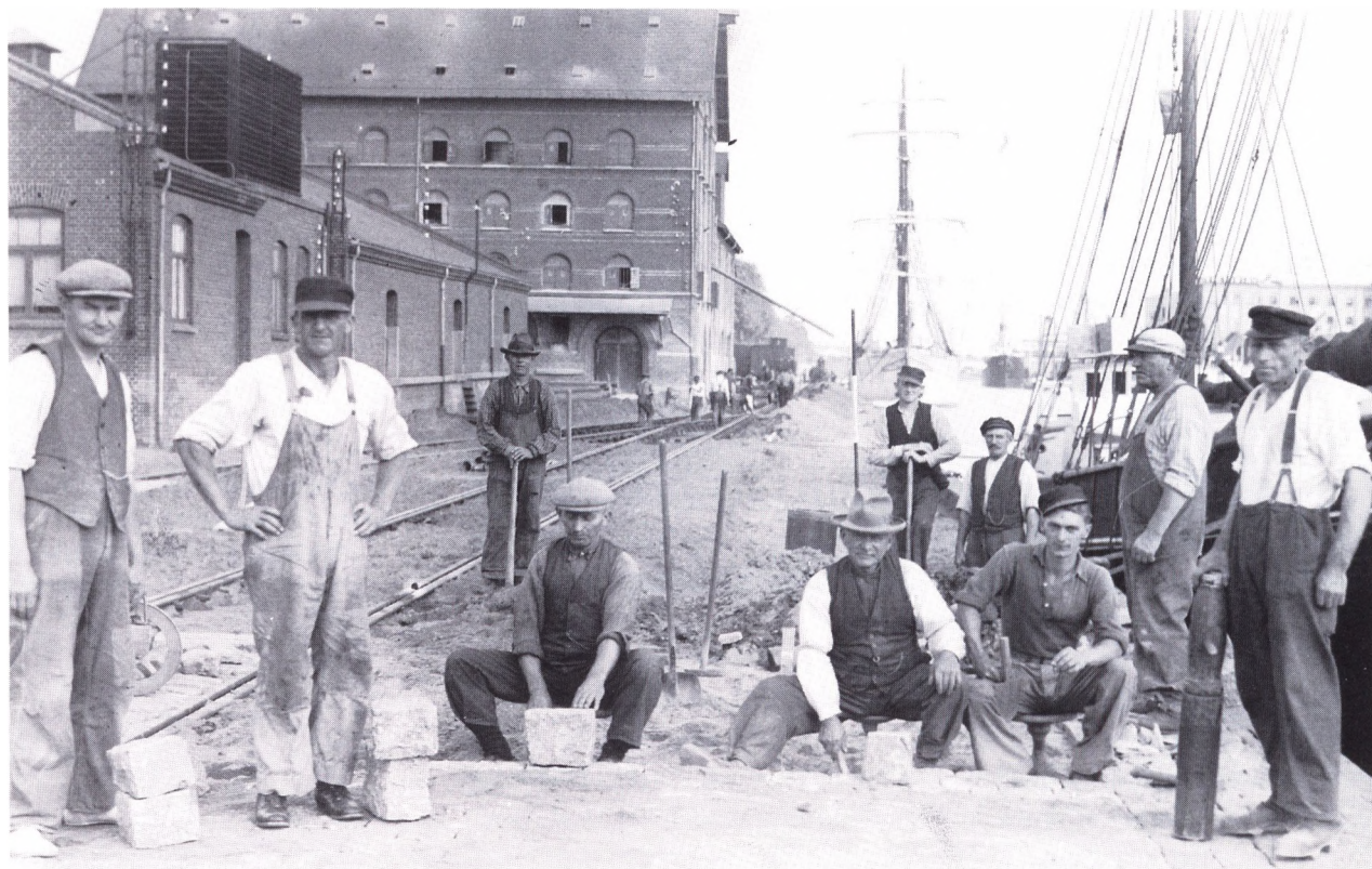
Brolæggere i arbejde ved Englands kajen. I baggrunden arbejdes der med jernbanesporene (Møntergården).
