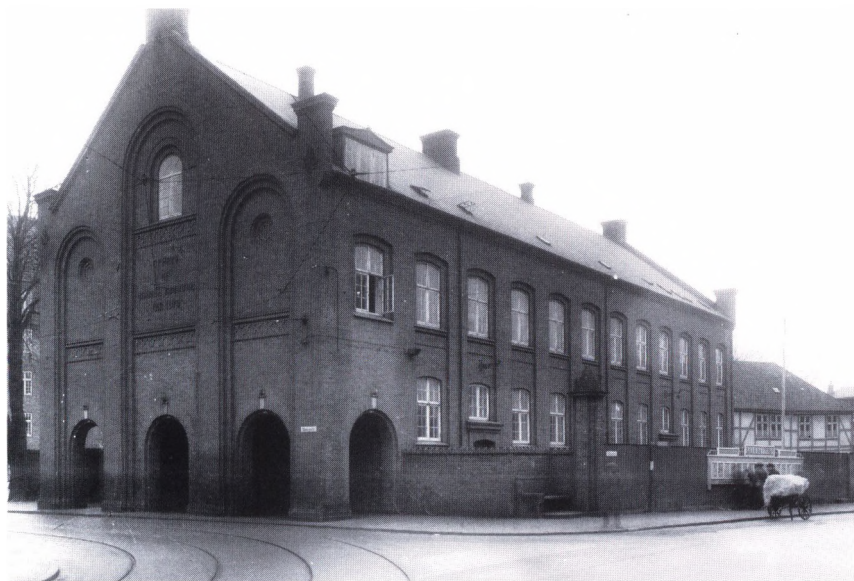
Klaregades Skole ved hjørnet af Mageløs – og i baggrunden til højre værneskolen i Holstedøre. Begge bygninger stod for fald efter at være forladt af skolevæsenet i 1934 (Montergården).
