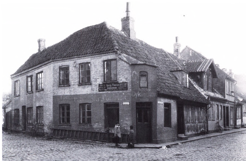
Hjørnet af Georgsgade og Frederiksgade fotografieret 1931 umiddelbart før nedrivningen af hjørneejendommen. En sneedkermester havde reklameskilt på huset (H. Lønborg fot., Møntergården).
