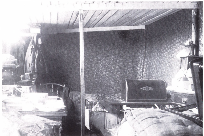
De to billeder på dette opslag viser noget om, hvor stor en forskel der kunne være på en husvildebolig og et finere embedsmændshjem i begyndelsen af vort århundrede. Billedet fra husvildeboligen er fra omkring 1925 (E. Biering fot., Møntergården).
