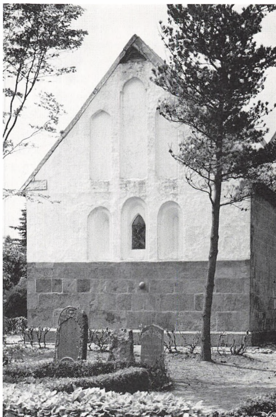
Fig. 7. Korforlængelsens østgavl med trekoblet vindue (s. 1242). NE fot. 1986. — Ostgiebel der Chorverlängerung mit Dreifenstergruppe.
