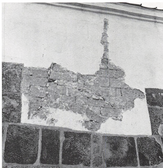
Fig. 14. Tuffstensmurværk i skibets nordmur (s. 1184). Knud J. Krogh fot. 1956. — Tuffgemäuer in der Nordmauer des Schiffs.
