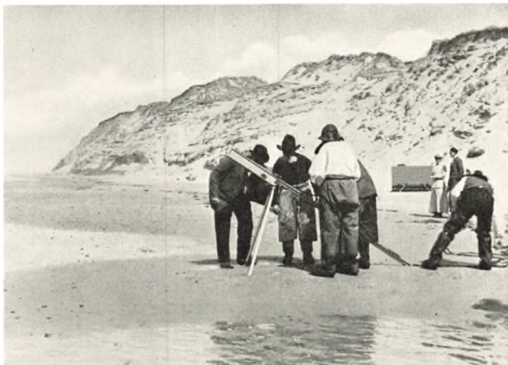
Arbejde med Redningsraket ved Lonstrup.
