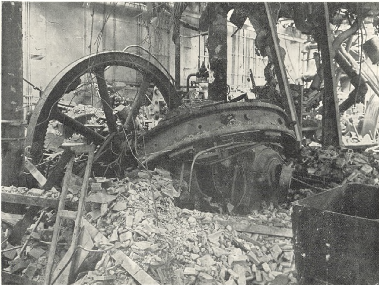
Tuborgs Maskinhal efter Schalburgtagen 1945
