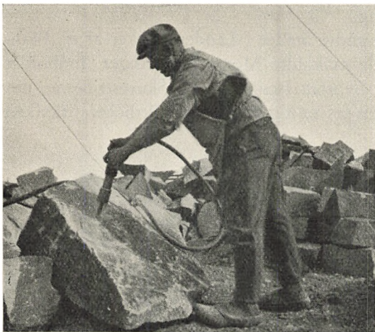
FOT.: ADOLPH Øverst Fremstilling af Chaussesten. Faldhammeren kløver Granitblokken ved et Tryk mod Mejselen, hvorpå Blokken hviler. — Derefter Kløvning af Granit. Der bores Huller i Granitblokkene.
