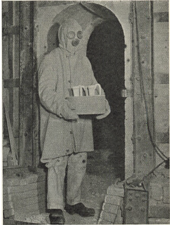
Ovnen tømmes efter Brændingen. Da dette gøres, mens den endnu er varm, er Asbestdragt ofte nødvendig.
