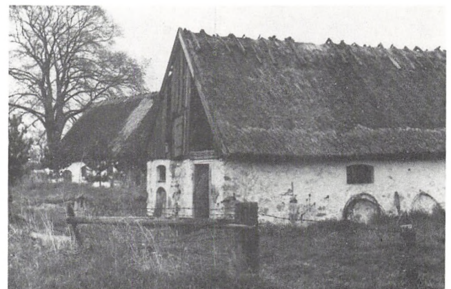
Brudegårdens avslænger før nedrivningen i 2. halvdel af 1900-tallet
