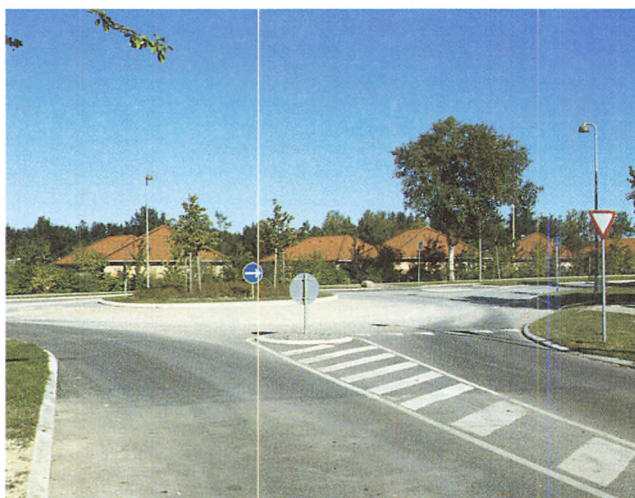
Rundkørsel ved Stavnsholtvej - Klintebakken
