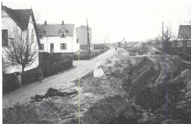
Ryttergårdsvej anlægges. Tv. Nygårdsvej (FAM)
