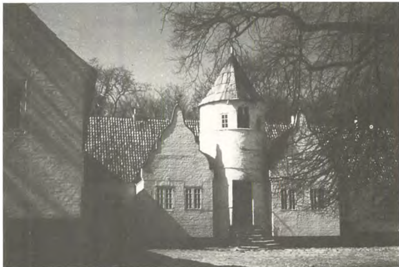
Randrups huse står usædvanlig uforandrede og afspejler i deres sammenstykning en byggetid, der spænder over tre århundreder.
