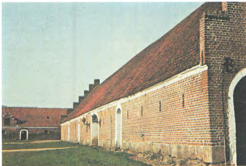
Det tog tyve år, 1668–88, at opføre Ulstrups anselige ladegård. Da den 1923 blev fredlyst under Det Særlige Bygningssyn og samtidig istandsat, måtte stråtagene udskiftes med tegl.
