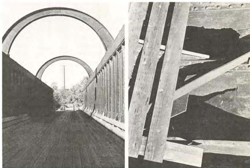
1864 sprængte tyskerne den knap to år gamle jernbanebro ved Langå , så den lå i vandet og spærrede al sejlads på Gudenåen . Under Anden Verdenskrig afbrød sabotører under ledelse af Randers-lægen Jørgen Røjel den jyske længdebane ved en stort anlagt sprængning af bl.a. den ny bro. Broen står der endnu, men bruges ikke mere til togtrafikken. Det er nok et af de få steder, hvor virkningerne af en sabotage stadig kan ses.
