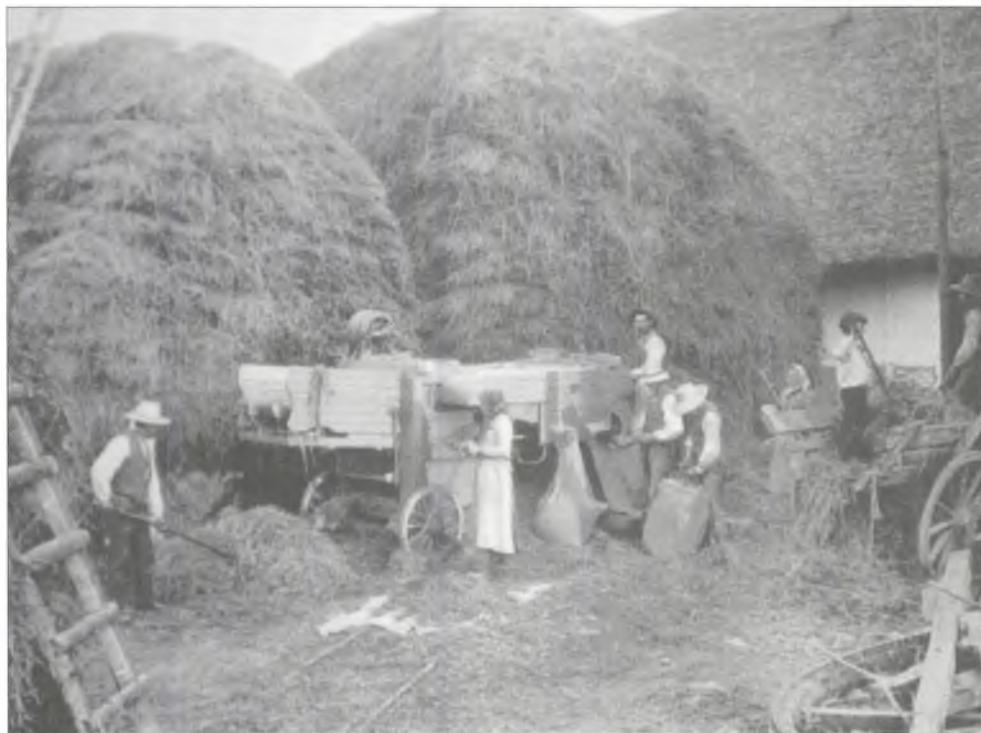
Tørskeværk drevet med elmotor, 1907. Motoren blev desuden anvendt til oppumpning af vand og til at skære hakkelse og roer. På gården (Lolland, 73 tdl.) blev der indlagt strøm allerede i 1906.
