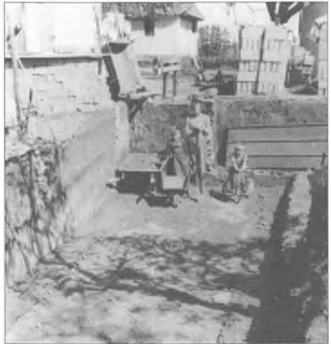
“Hele familien hjælper med støbning af ajle-beholder” (Midtjylland, 1960).
