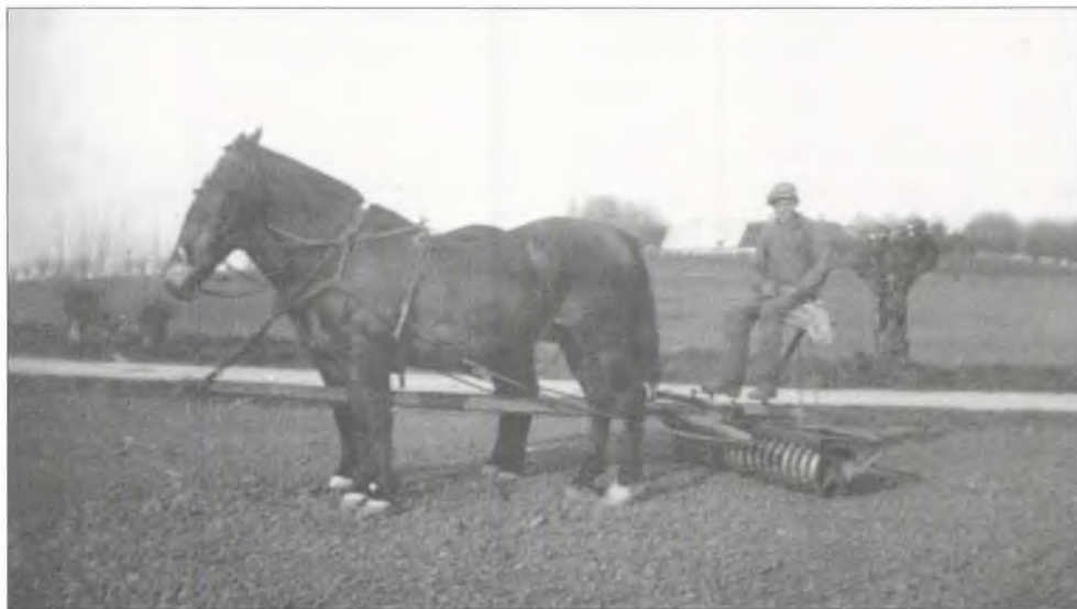
På ringtromlen, foråret 1934. Efter såningen blev der samlet sten og tromlet, men på en type som denne med agestol på rammen, "måtte man passe på ikke at falde i søvn" (Fyn).
