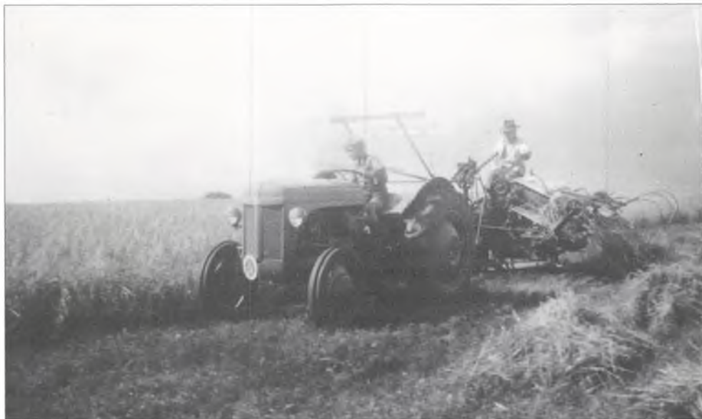
Traktorbinder med kraftoverføringsaksel, der gav et mere stabilt træk end hestebinderen (Fyn, 1954).
