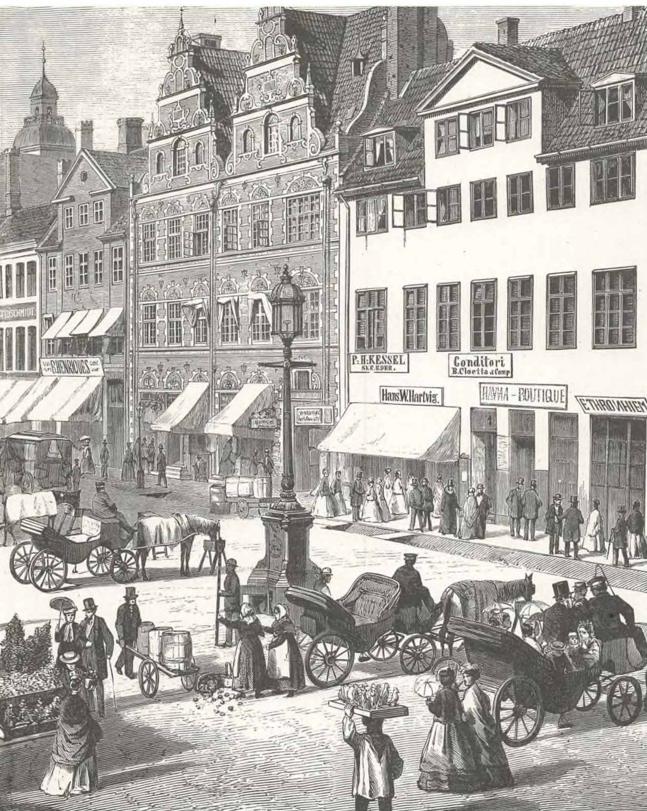
tore og prangende bygninger. På pladsen venter tidspunkt. [Bernhard Olsen] (Ill. Tid. bd. 9, 1867-68, s. 166)
