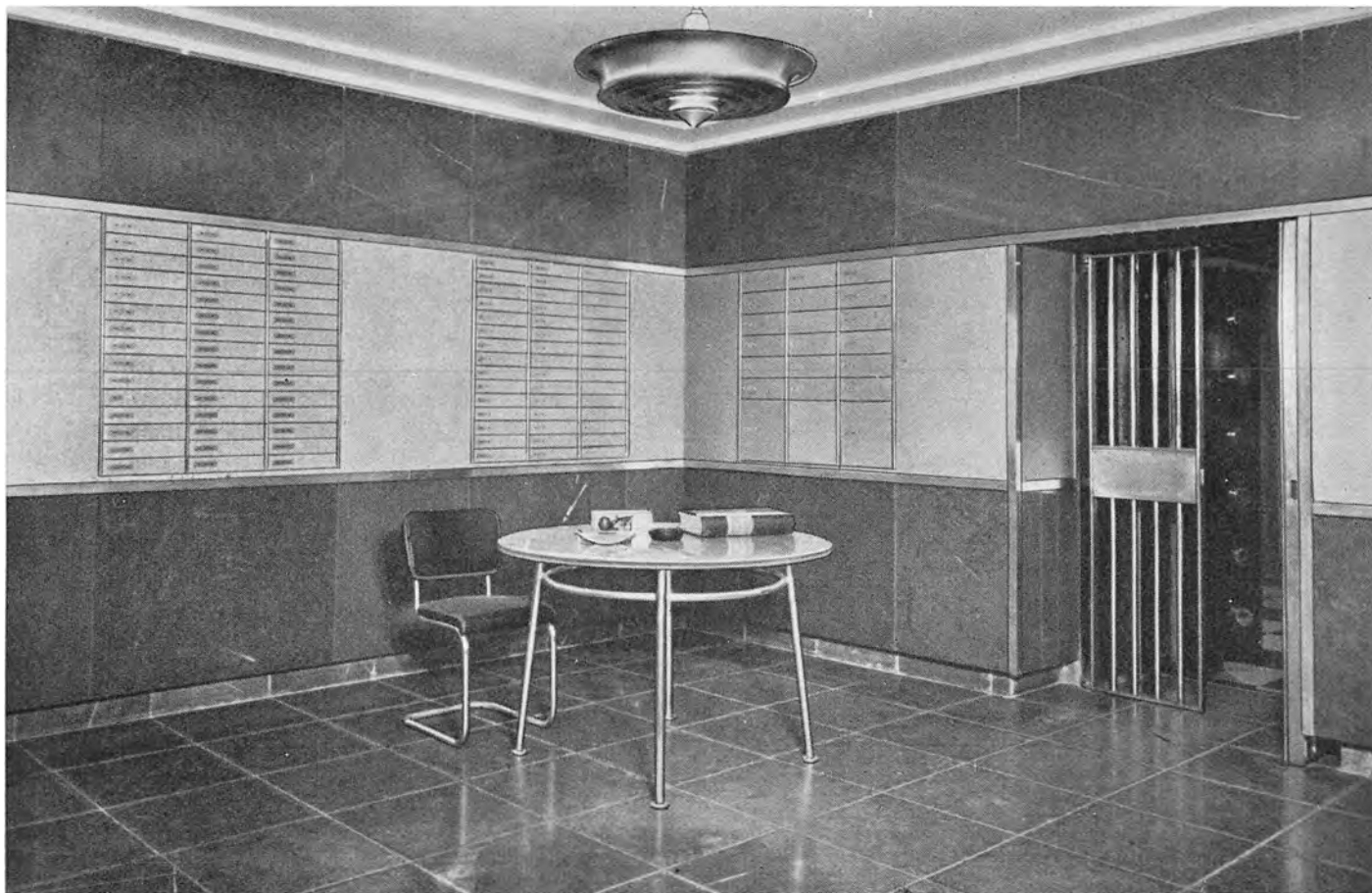
Varde Bank: Fra det store Kælder- og Boksanlæg under Hovedsædet i Varde. Et Hjørne af Kælderen med Kunde-Boksene.
