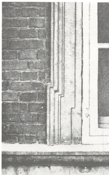
Fig. 17: Detalje af sandstensindfatning om et af 1'ste sals vinduer i Kancellibygningen. Man ser det forhuggede murværk. (Fot.: Arne Nystrøm, 1942).
