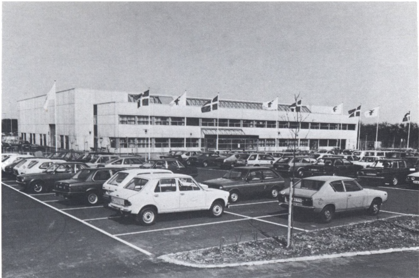
Det tidligere Fyns Forum på Sortebrødre Torv måtte vige pladsen for det nye kongrescenter, og det er siden opført som et moderne messecenter ved Ørbækvej sydøst for byen.
