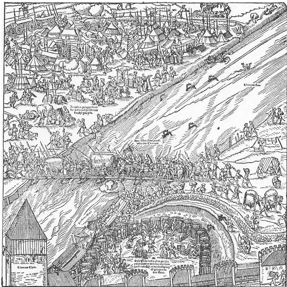
PONTONBRO, BEFÆSTET BROHOVED OG BEFÆSTELSE AF FLODBREDDEN I DET 16. AARH. Kobberstik af Hans Mielich fra 1549, der viser Ingeniørarbejder om o Kejser Karl V's Lejr ved Ingolstadt. Fot. Folker.
