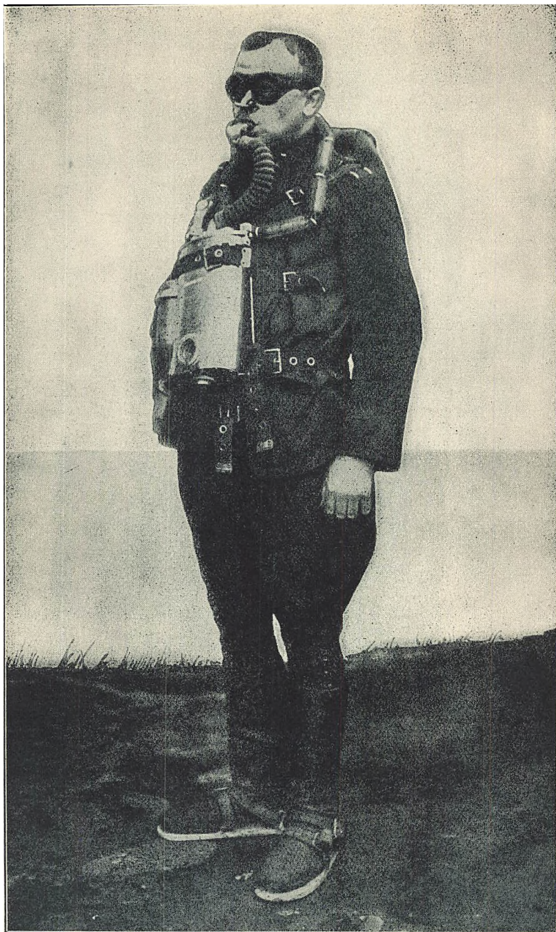
80 Overassistent Georg Larsen iførl „Drägers“ Badedykker-Apparat.
