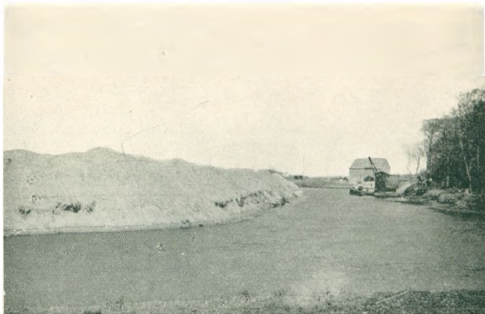
Aaen uddybes. Gravemaskinen ses foran Bygningen.
