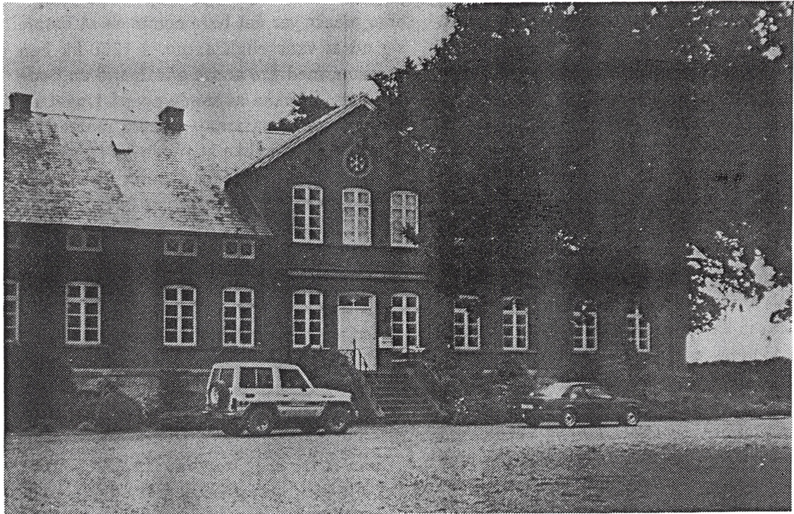
Den nuværende hovedbygning på Dalagergård. Th. skimtes det egetræ, der i generationer har stået midt på gårdspladsen. (Foto: Per Andersen)
