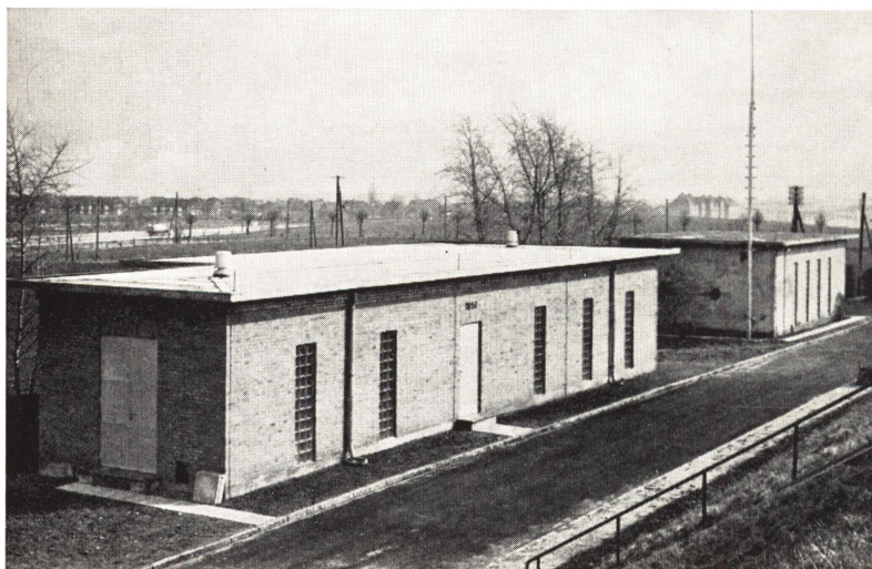
Højtrykzone pumpestation i Bolbro.
