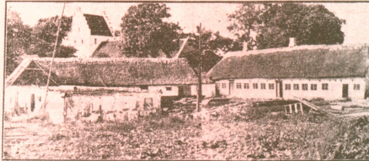
Den gamle Gaard i Dalby, der nu bliver revet ned. I Forgrunden s. B. Højskjængen, i B. Højskjængen, der rummer den husekonstruktive Skovsæ. — I en Udsigt, der rækker ud over Haven.
