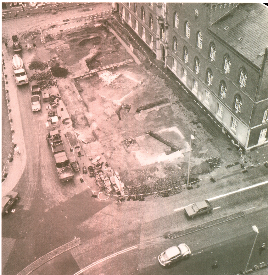
Fig. 8. Oversigtsbillede af de to husfundamenter taget fra Skt. Knuds kirkes tårn. Omtrent vinkelret på Rådhuset ses området for laboratoriebygningen. Begyndende ud for rådhusindgangen strækker Kancellibygningen sig i sydvestlig retning ud mod afspærringslinien. En ældre fjernvarmekanal adskiller Kancellibygningens kældertrappe fra arkæologernes »luksushul«.
