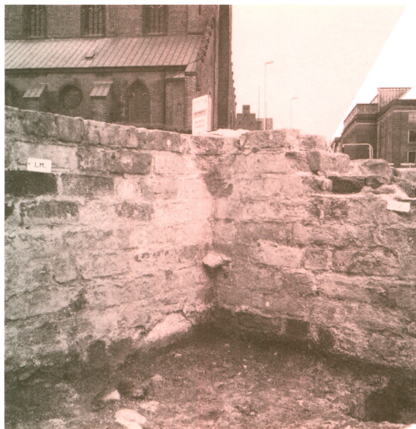
Fig. 10. Det bærende fremspring i det sydvestre hjørne af Kancellibygningsens kælder var det første synlige bevis på overhælvningen.
