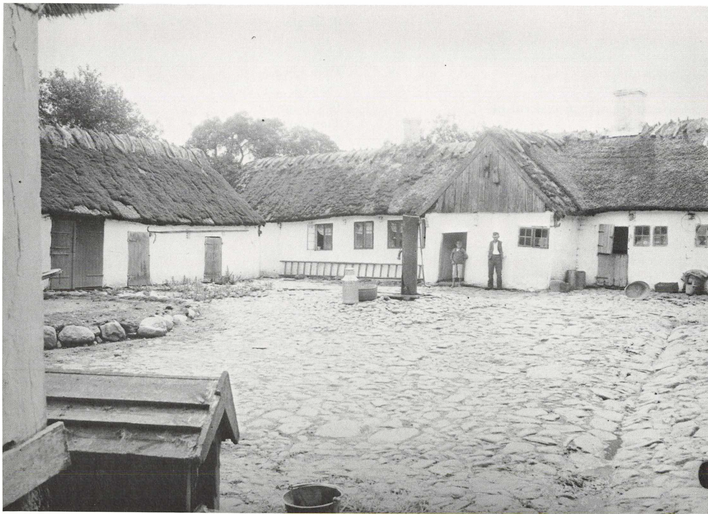
Gårdsplads med bislag fra Kirkerup sogn og by. Det var netop typisk for de vestsjællandske gårde at have bislag ud til gårdspladsen. Søren Pedersen byggede flere gange sit om og flyttede også rundt på det. Nat.foto.
