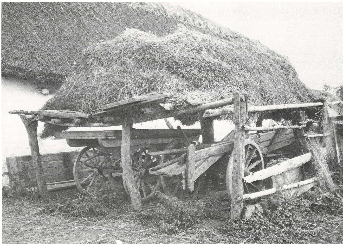
Vognbod, fra Arnhauegården i Lyngesogn. Gården, der var bygget i 1600-årene, blev gennemfotograferet før 1920 af Zangenberg. På det tidspunkt var gården helt forfalden. Vognboden ser så forfalden ud, som Søren Pedersen aldrig ville have accepteret det på sin gård. Til gengæld viser den udmærket den klassiske opbygning med naturgroede hjørnestolper og et massivt halmtag – brugt i løbet af vinteren til foder. Nat.fot.
