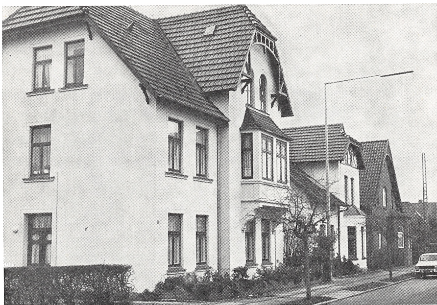
Forstalle 19–23. Repræsentative villaer og etagehuse opført 1906–09. Stilen stærkt påvirket af det tysk-nationalromantiske officielle byggeri. Husene er gode eksempler på den kombination af villa og byhus, der skete i disse år, – den forreste ejendom er et etagehus med 3 lejemål, de to bageste huse var enfamiliehuse.
