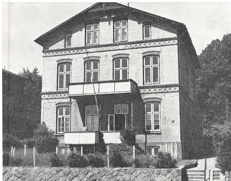
Det første »Kommodehus«, »Friedensheim«, Haderslevvej 11 (nu nedrevet). Opført 1894 af bygmester Peter Callesen. Alle de typiske træk ved schweizervillaerne genkendes også her.
