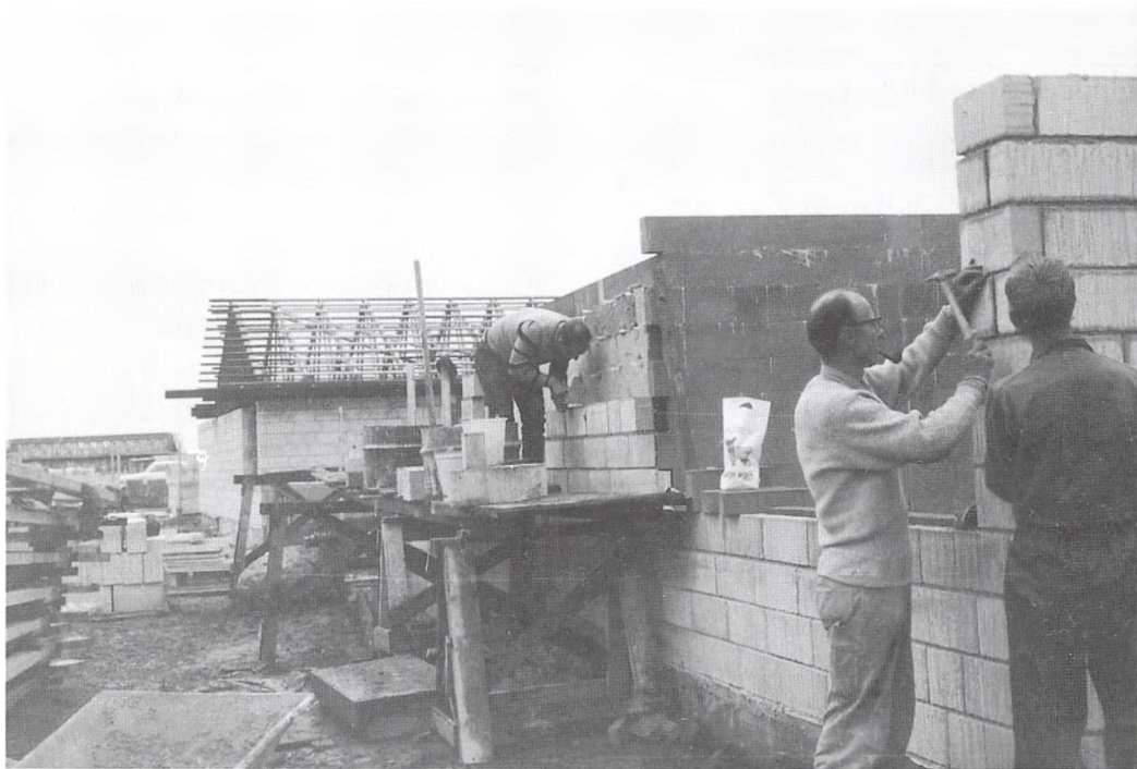
Familien Kruse sætter de sidste gasbetonsten på plads. (Flemming Kruse)
