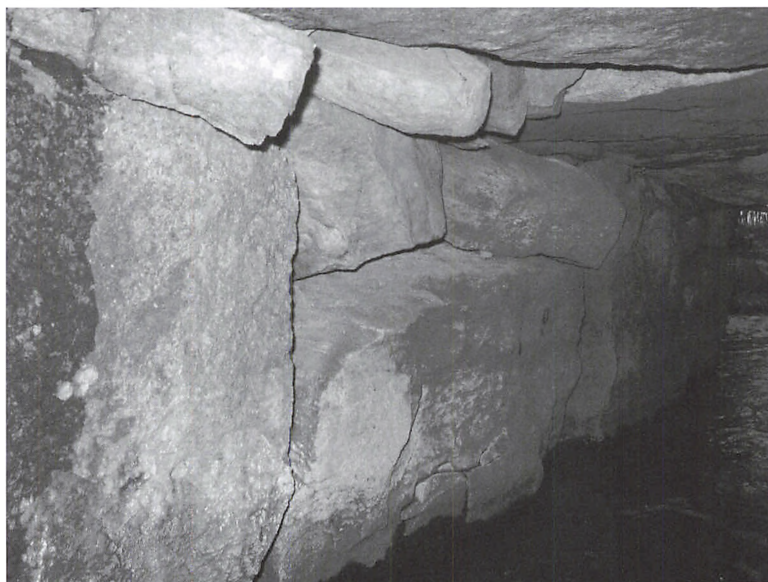
Den lodrette stensætning (væg) mod nord, set fra den vestvendte åbning.
