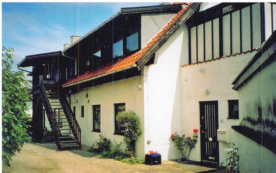
Ejendommen "Øresundshøj" som den ser ud efter ombygningen. (Fotos april 2002).
