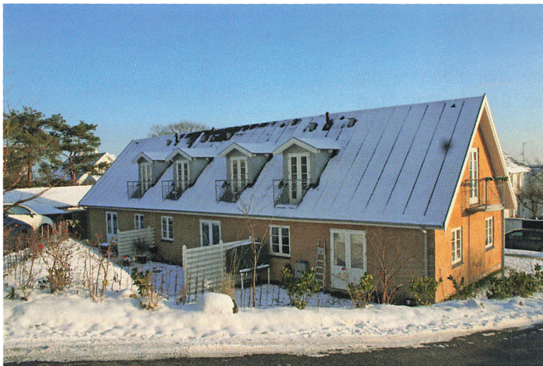
Gydevej nr 14 A-B fotograferet i dec. 2012 - set fra hjørnet ved Gratiavej.
