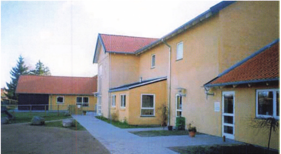
Efter branden blev bygningen genopført, men nu i anderledes udformning og indretning. (Foto nov. 1999)
