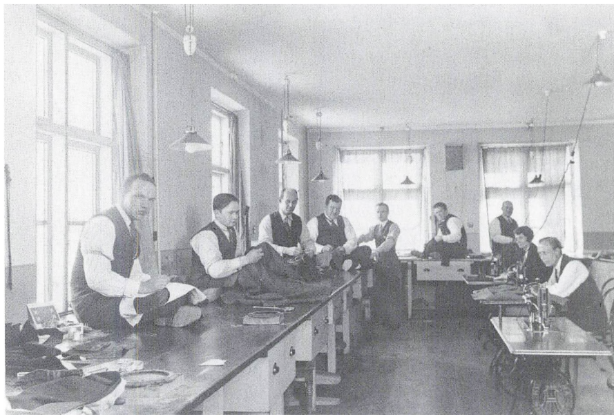
Et lyst og moderne provinsværksted: Skrædderfirmaet Brøsch, Hillerød. Arbejderbevægelsens Bibliotek og Arkiv.
