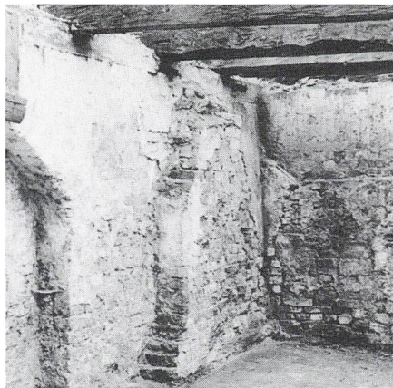
Fig. 13. Muret vange. Rest af det oprindelige køkkenildsted i sidefløjens kælderetage. (Fot. 1944 i Københavns Bymuseum).
