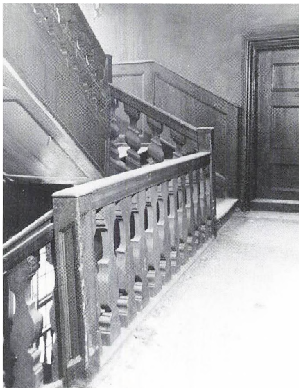
Fig. 19. Den store baroktrappe i det omkring 1725 opførte trappehus set fra salselagens hovedrepose. (Fot. 1944 i Københavns Bymuseum).
