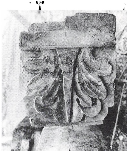
Fig. 6. Udskåret bjælkehoved på en af gårdsidens bevarede svalegangsbjælker. (Fot. 1944 i Københavns Bymuseum).
