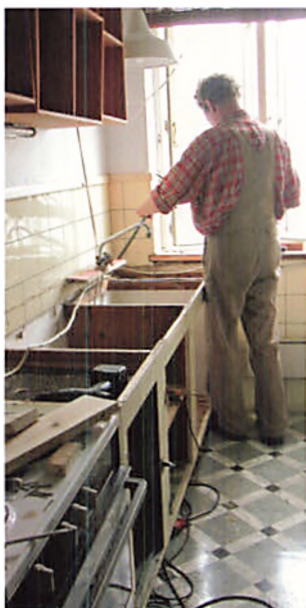
Den Gamle Bys tømrerformand, Ejvind Malthesen, i gang med at nedtage et køkken fra 1930'erne.
