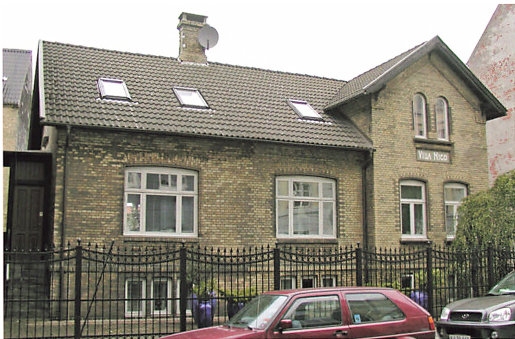
Solitært hus, Århus, opført 1890.
